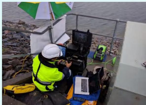
澳洲 Mount Piper 火電廠利用遙控潛水器為冷卻水進水塔進行檢查工作。
